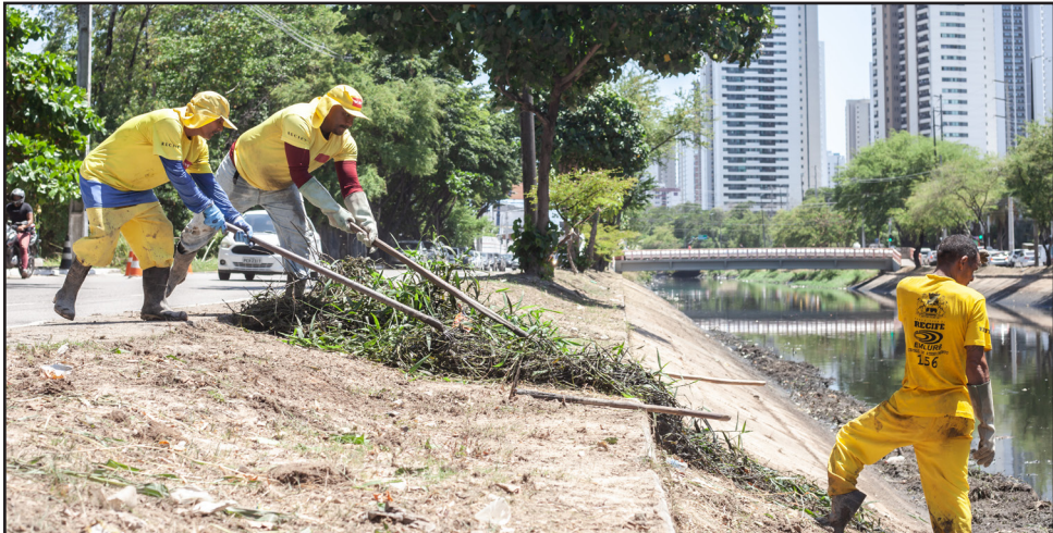
Equipes da Prefeitura do Recife percorreram quatro quilômetros de extensão do curso d'água realizando a retirada de equipamentos irregulares
