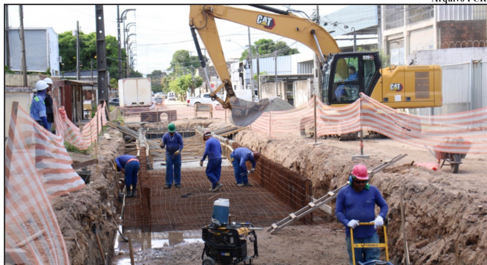
Obra terá investimentos da ordem de R$ 37 milhões, para reduzir o histórico problema dos alagamentos na região
