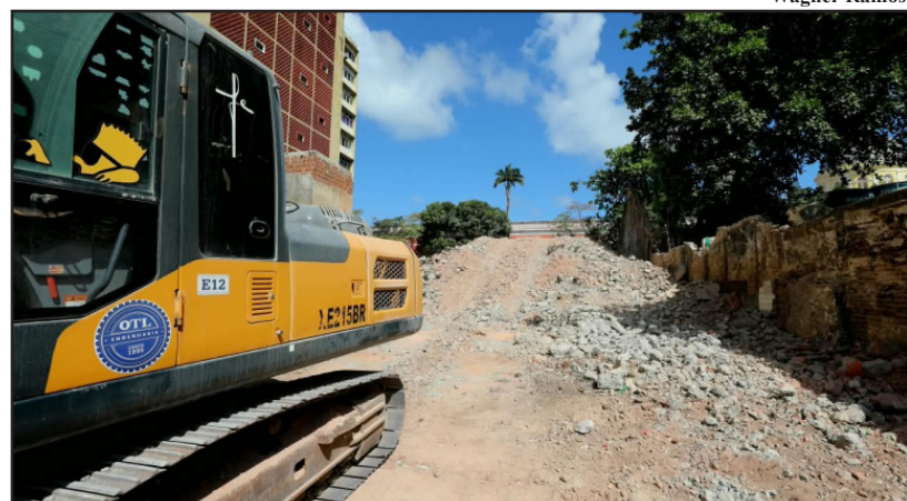
Trabalhos entram agora na fase de derrubada das fundações e remoção dos materiais
