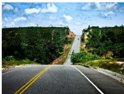
Trecho rodoviário da Linha Verde
