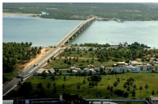
Ponte Gilberto Amado sobre o Pontal do Saco.
