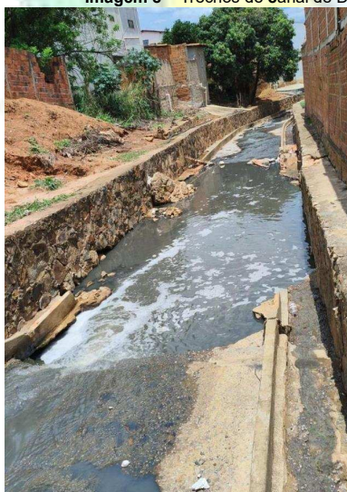
Imagem 09 – Trecho de canal de Drenagem urbano com parede, canaleta e piso danificados
