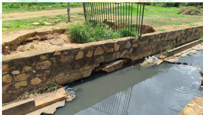
Imagem 04 – Trecho de canal de Drenagem urbano com piso, canaletas e paredes danificadas
