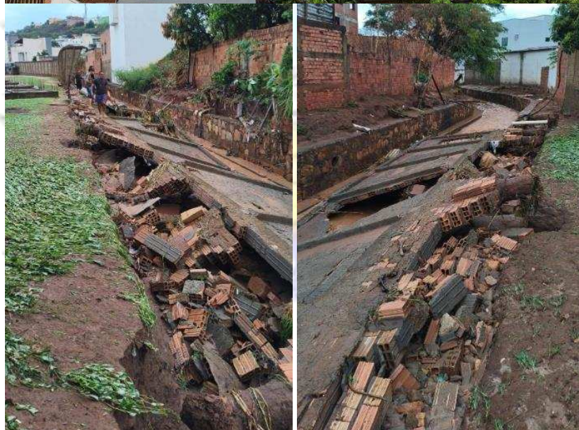
Imagem 02 – Trecho de canal de Drenagem urbano com piso erodido
