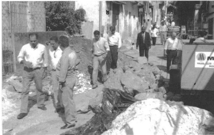
O prefeito fez questão de visitar ontem várias obras de infra-estrutura
