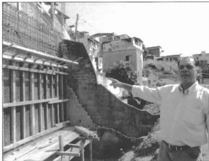
O prefeito mostra a contenção que está sendo feita em uma das encostas
