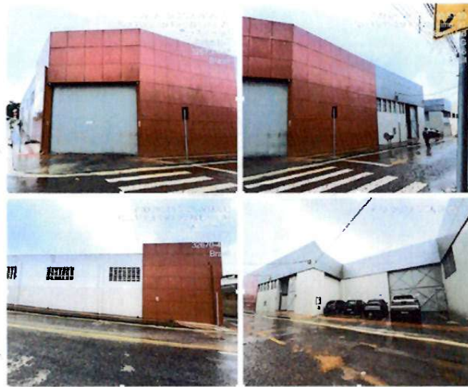
Figura 07 -Registro fotográfico retirado do relatório nº12/2026 de vistoria da Divisão de Educação Urbana e Fiscalização de Obras Privadas da Secretaria Adjunta de Planejamento Urbano
