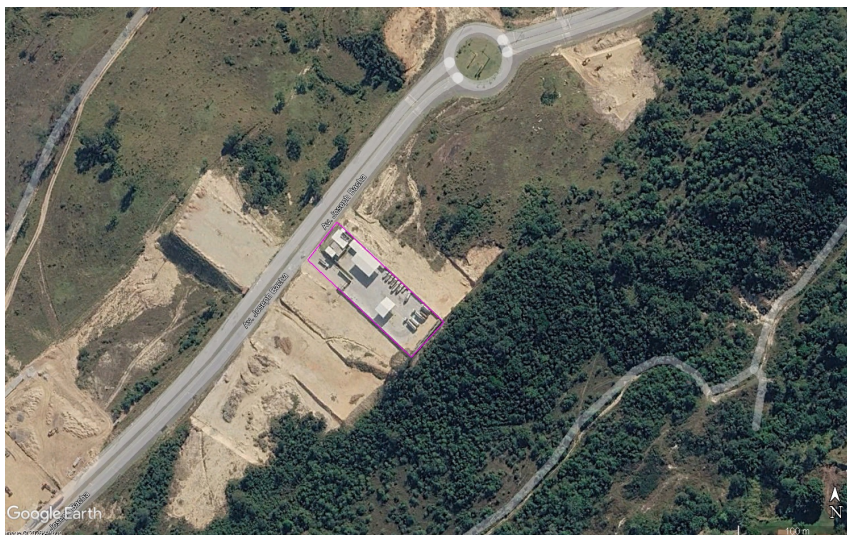
Imagem 06: Localização do empreendimento retirado do Google Earth .
