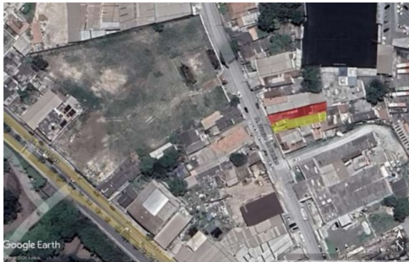
Imagem 13: Localização do empreendimento retirado do Google Earth .
