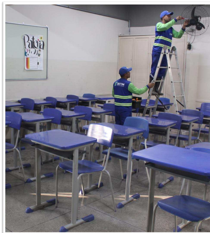
Figura 4 — Manutenção em ventilador de escola municipal
