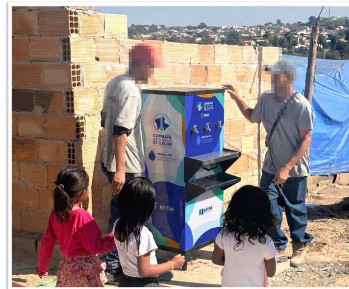
Figura 1 — Instalação de bebedouro – Comunidade indígena Warao
