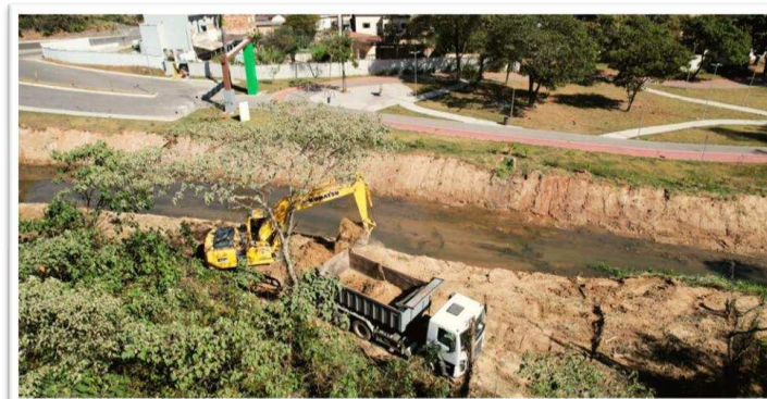
Figura 12 — Desassoreamento do Rio Bandeirinhas - Bairro Citrolândia
