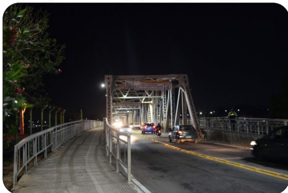
Ponte Florentino Avidos recebeu nova iluminação
