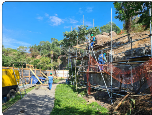
Operários executam obra de contenção no parque.
