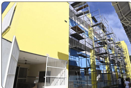
Visita às obras da Emef Ronaldo Soares
