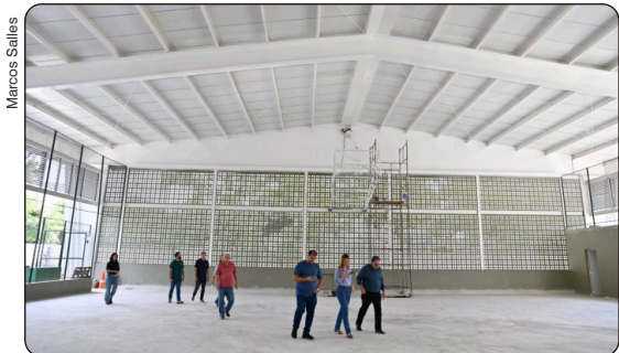
Visita técnica a obras da praça Regina Frigeri Furno
