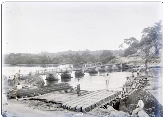
Construção da nova Ponte da Passagem. Ano 1927.
