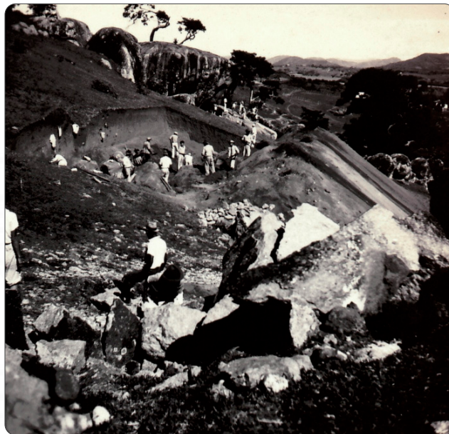
Operários quebrando rochas para passagem da Estrada do Contorno.
