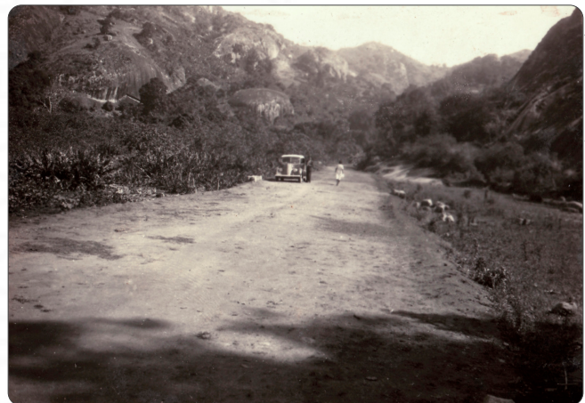
Trecho da obra da Estrada do Contorno da Ilha de Vitória
