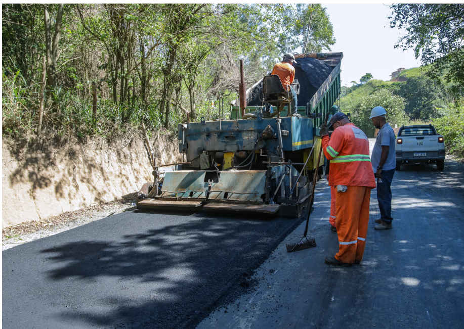
A previsão é que aproximadamente 23 km sejam asfaltados no primeiro pacote de obras.
