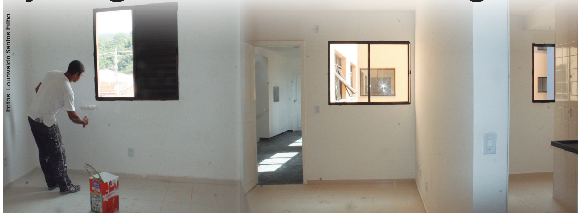
Pintor trabalha no acabamento de um dos 700 apartamentos, que têm cômodos amplos, azulejos e pisos colocados
