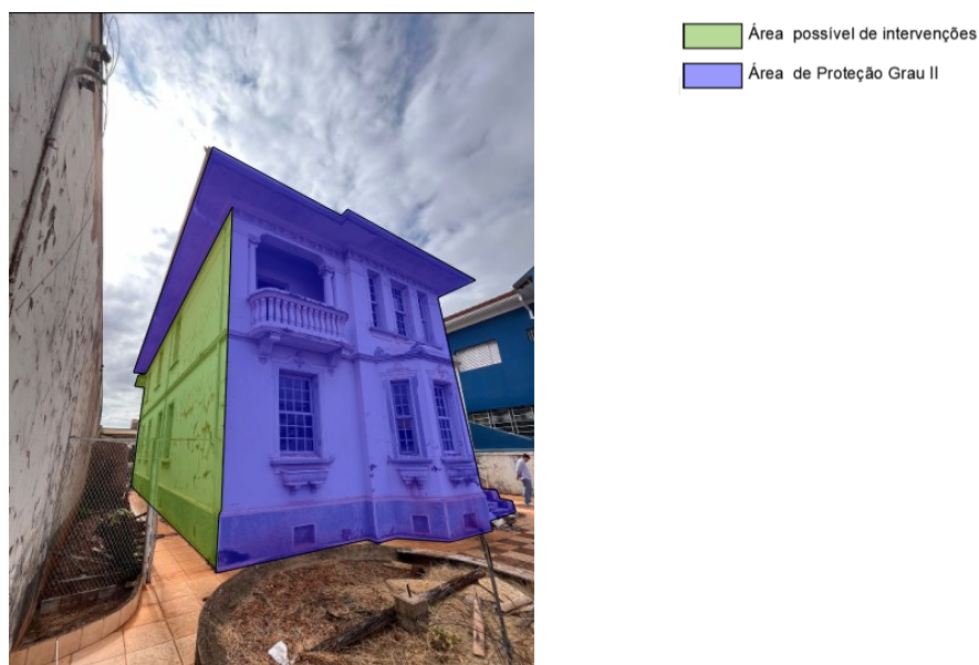
Imagem 3: Fachada Frontal do imóvel
