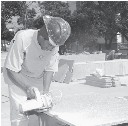
Trabalhadores finalizam os trabalhos para a inauguração da Praça das Águas no próximo sábado
