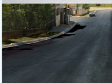
Jardim Ritoni Pavimentação e construção de galerias na Rua Occilio Ritoni 6.500 m 2 de asfalto Obra concluída
