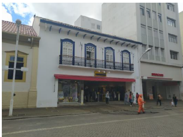
Aspecto recente da fachada do imóvel Foto em 26 de outubro de 2020 - Fonte: DPH
