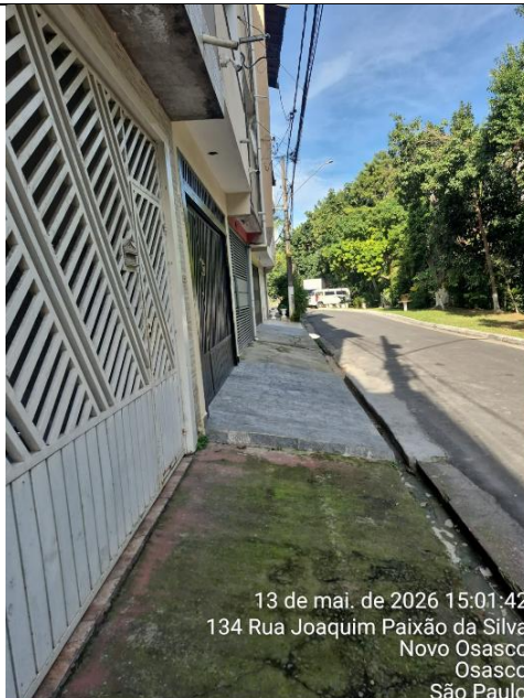
Imagem 08 – Calçada (lado esquerdo), área das edificações residenciais
