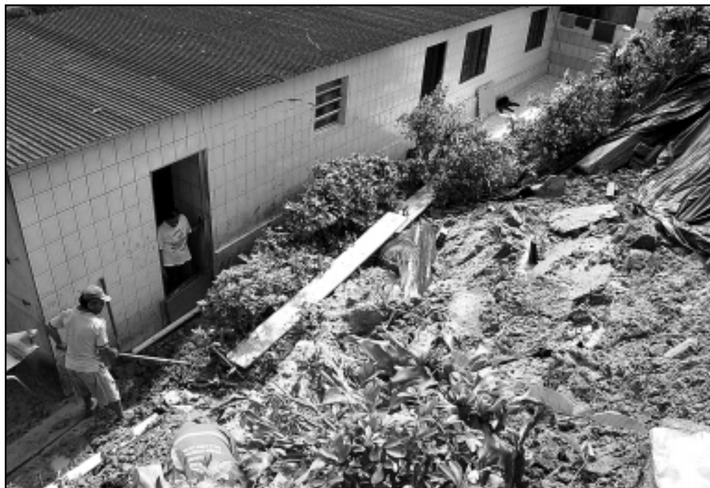
Equipe da Defesa Civil constatou que não havia necessidade da retirada de moradores da casa, na Rua F
