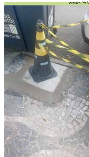
Troca de tampa de concreto Rua Nabuco de Araújo, nº 703, na Aparecida
