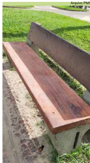
Troca de assento danificado na Avenida Vicente de Carvalho, nº 31, no Boqueirão
