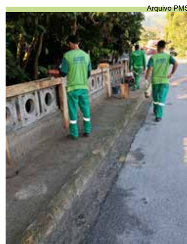
Montagem de formas na mureta na entrada do Caruara
