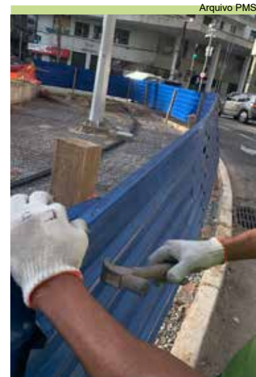
Serviço de retirada de tapumes na Praça Independência
