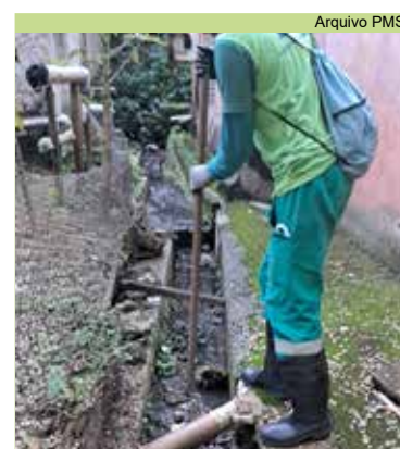
Limpeza de córrego, canaleta e grelhas na Rua 6, no Morro José Menino
