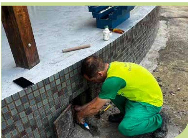
Reparo de vazamento na torneira do palco da Praça Johanne Jensen, no Monte Cabrão
