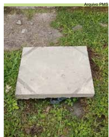
Colocação de tampa de concreto na Rua Castelo Branco, no Caruara
