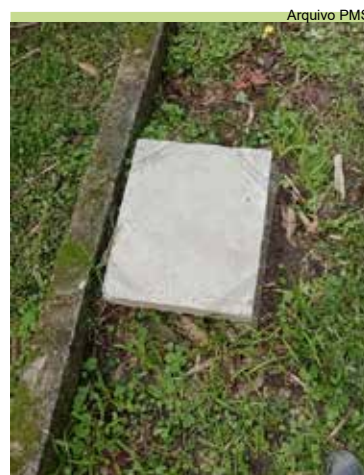
Instalação de tampa de concreto na Rua Dorothy Muroccco
