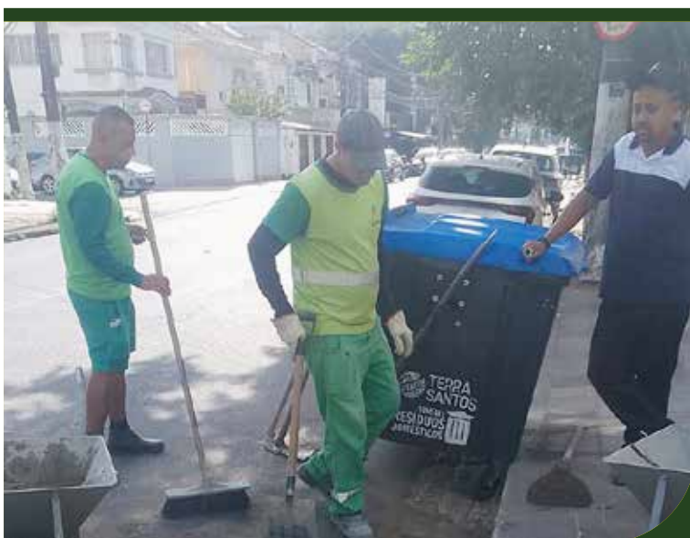
Instalação de boca de lobo no cruzamento das Ruas Oswaldo Cochrane com Aureliano Coutinho, no Embaré
