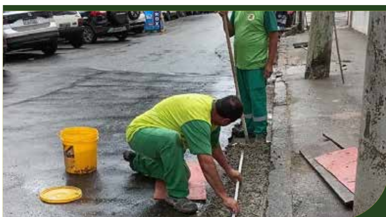
José Menino: concluída concretagem de sarjeta no trecho das ruas Rio Grande do Sul/Newton Prado
