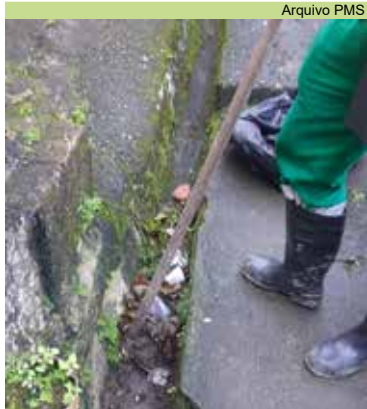
Rua São Caetano, no São Bento, ganhou manutenção de canaletas
