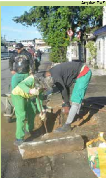
Acessibilidade: realizado rebaixamento de calçada na Rua Hugo Maia
