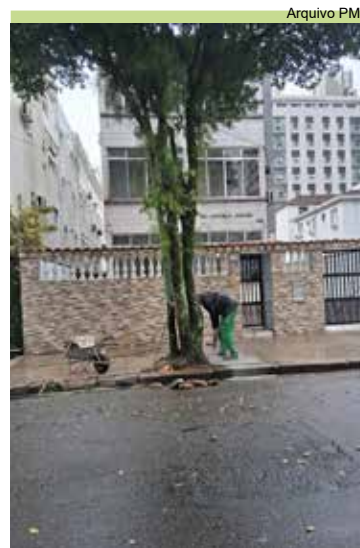
Zeladoria fez abertura de berços para árvores na via Gonçalves Ledo
