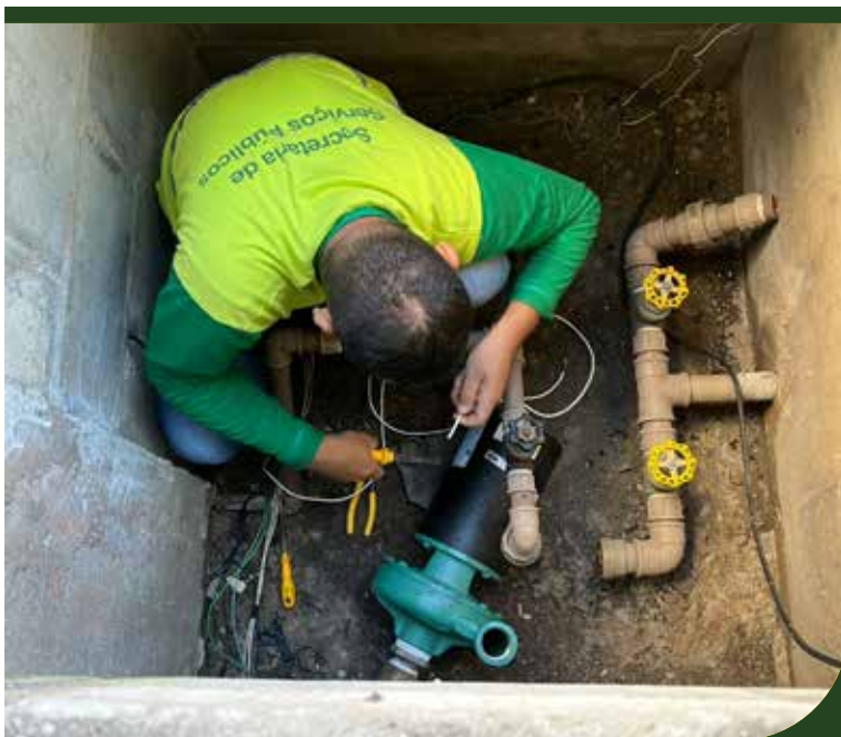
Zeladoria fez manutenção de bomba hidráulica na Vila Criativa Sênior
