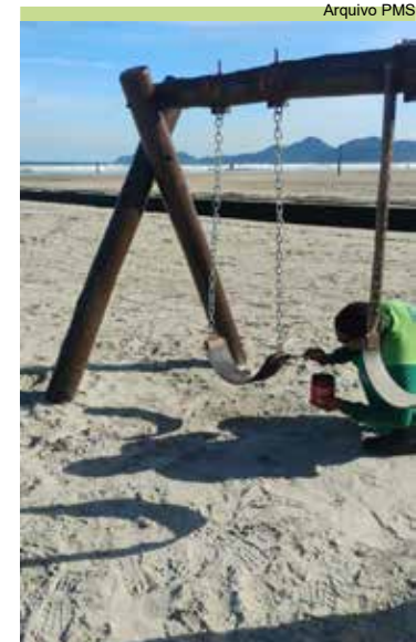
Novos balanços instalados na praia, na altura do Canal 3
