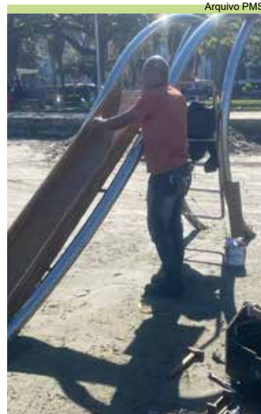
Instalação de escorregador na Orla, próximo à Fonte do Sapo
