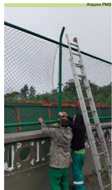
Caruara: zeladoria realizou reparo de alambrado em área de convivência
