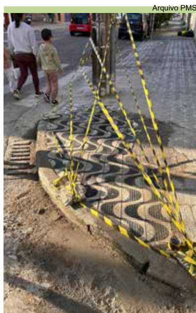
Reparo de calçada entre as vias Enguaguaçu x Cyro de Athayde
