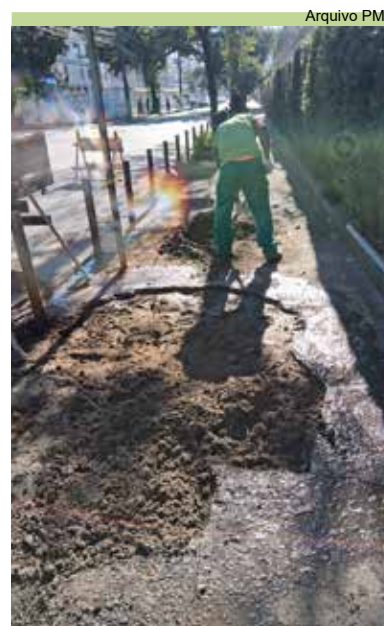
Concretagem de calçada na Rua Professor Pirajá da Silva
