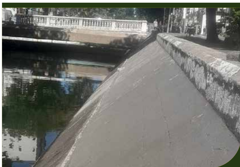
Programa Procanais: talude do canal 1, entre numerais 792 e 850, receberam manutenção
