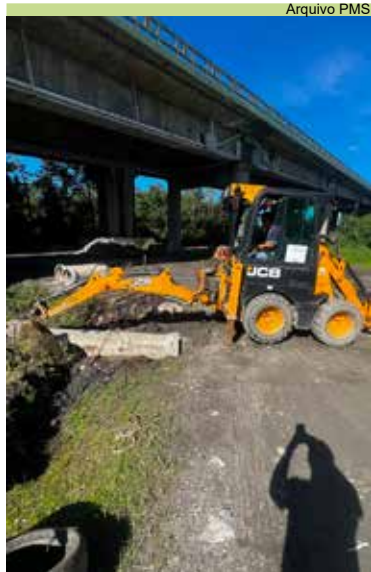
Manilhas de drenagem foram instaladas por equipes no Monte Cabrão
