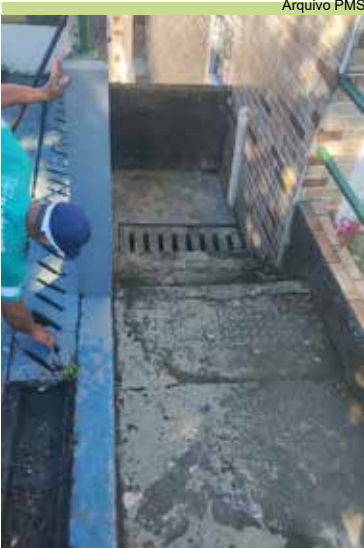
Rua 10, no Pacheco, foi contemplada com manutenção de grelhas
