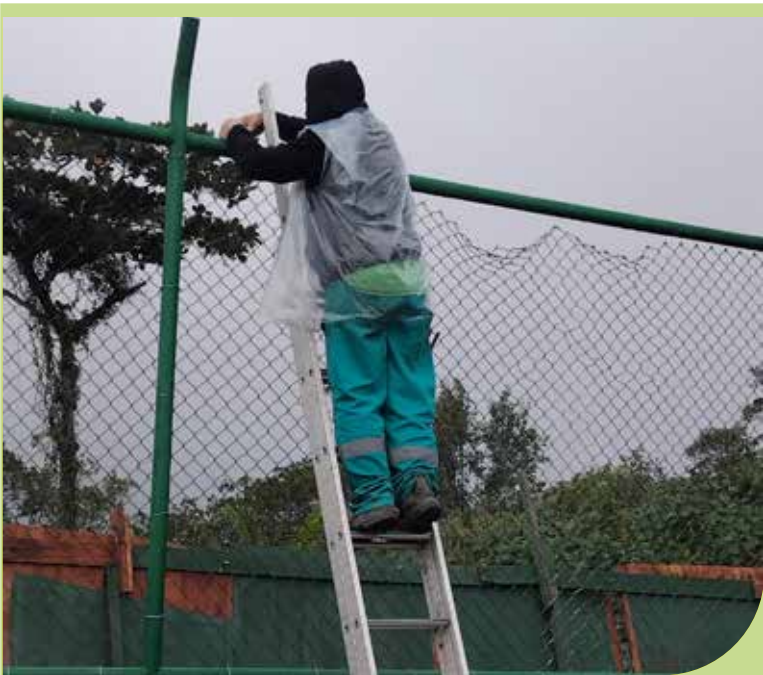
Zeladoria realizou manutenção de alambrados em área de lazer no Caruara
