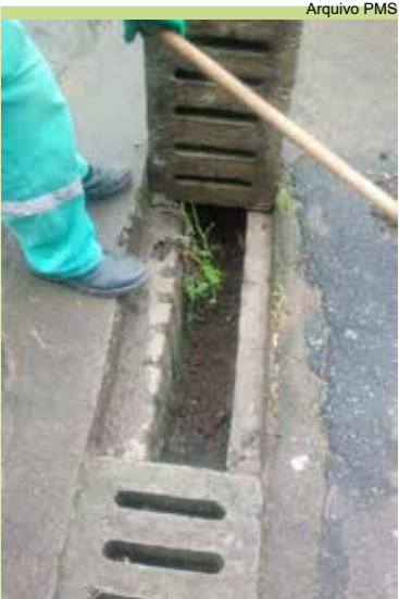
Grelhas da via São Sérgio ganharam trabalhos de limpeza
