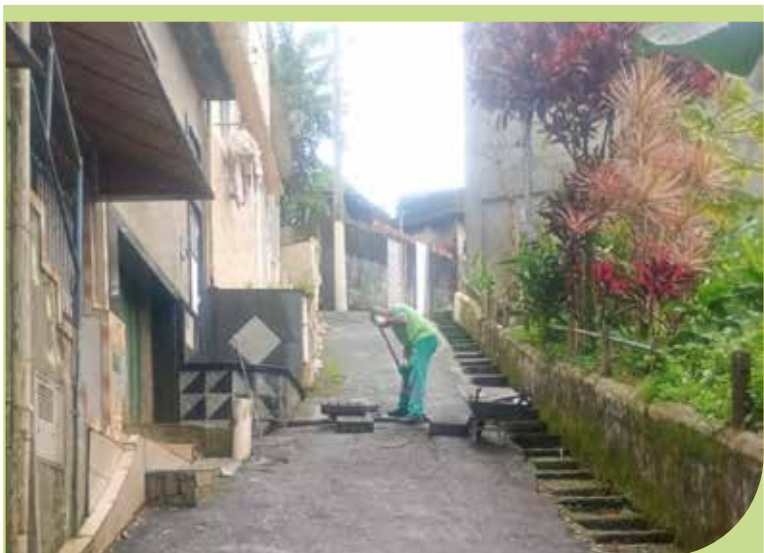
São Bento: feita limpeza de grelhas Travessa São Manoel
