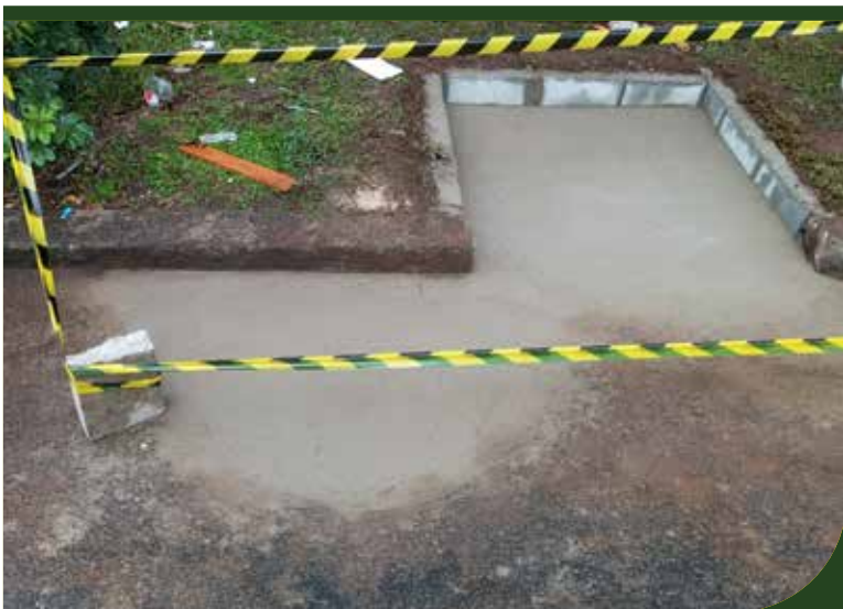
Concluída construção de baia para contentor de lixo na via Alfredo Ximenes, no José Menino
