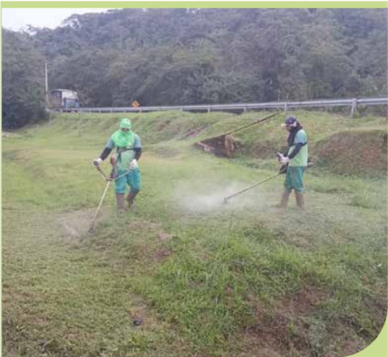
Rua Particular C, no Caruara, foi contemplada com trabalho de roçada
