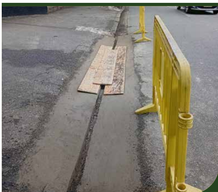
Nivelamento de sarjeta na Avenida Francisco Glicério, em frente ao número 305, no Gonzaga
