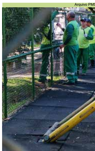
Realização de reforço na tela do alambrado da Praça Olímpio Lima
