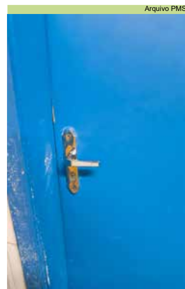
Colocação de novas dobradiças e de maçaneta trocada no Posto 2, na orla do Gonzaga
