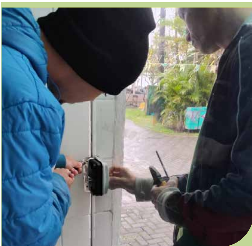
Manutenção da porta de acesso à Policlínica da Ilha Diana
