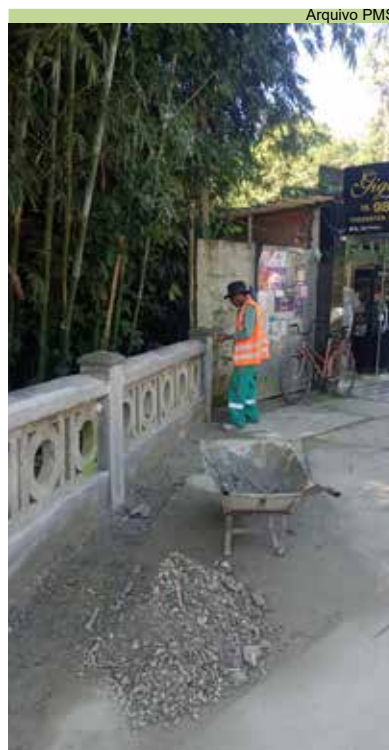
Finalização da construção da mureta na entrada do Caruara
