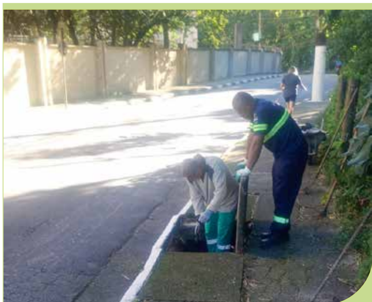
Serviço de limpeza de caixas na Avenida Antônio Manoel de Carvalho, no Morro Nova Cintra
