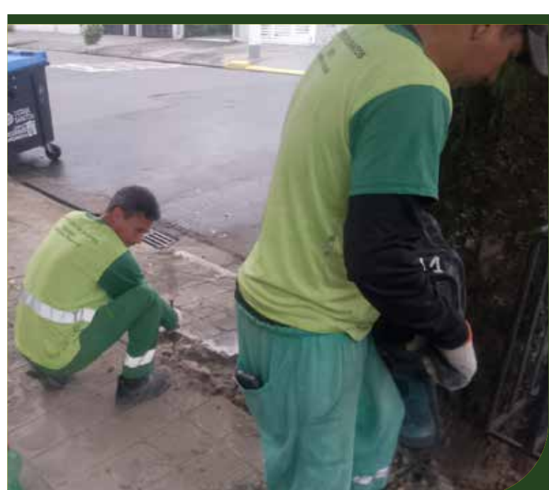
Serviço de abertura de berço e reparos no piso Copacabana em calçada na Rua 9 de Julho, no Marapé
