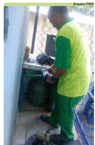
Instalação de portão na instalação de gás na UME Monte Cabrão
