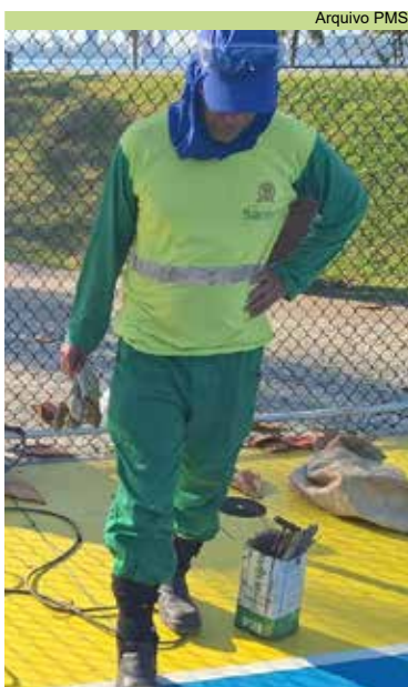
Reparo na estrutura do alambrado da quadra 3x3 do Emissário
