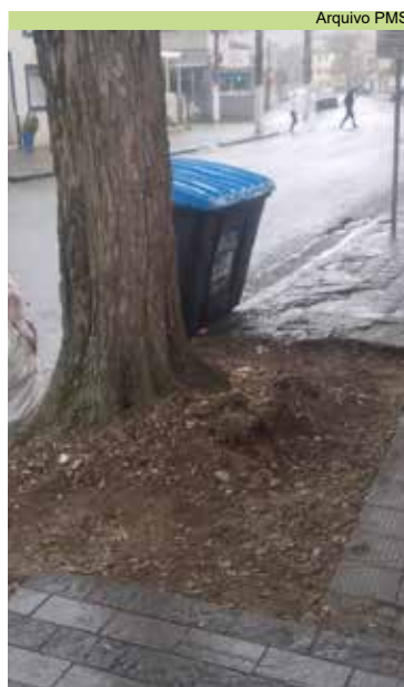
Abertura de berço e conserto de calçada na Rua Álvares Cabral, na Vila Belmiro
