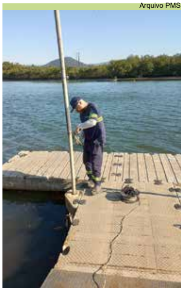
Serviço de manutenção no píer da Ilha Diana
