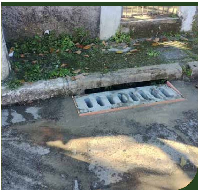
Troca de grelha de boca de lobo na Rua Marcos Vendramini, no Castelo
