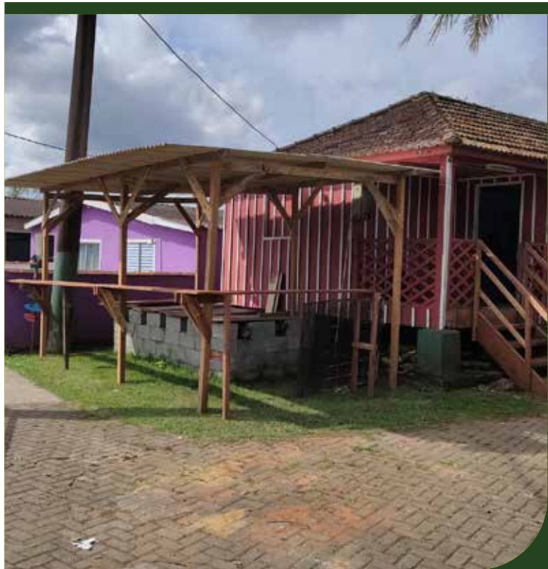
Construção da cobertura da barraca de churrasco na Ilha Diana
