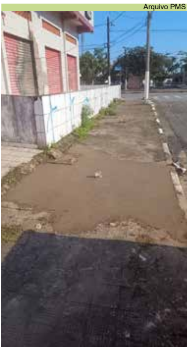
Reparos na calçada da Rua Alberto de Carvalho, no Santa Maria
