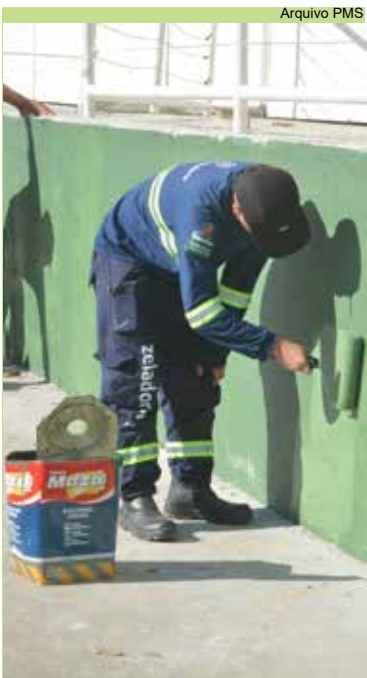
Manutenção no prédio do Sambódromo, na Avenida Afonso Schmidt
