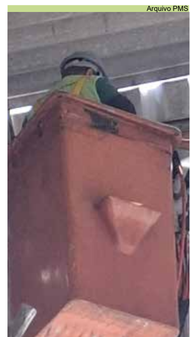
Serviço de manutenção na iluminação da quadra esportiva no São Manoel
