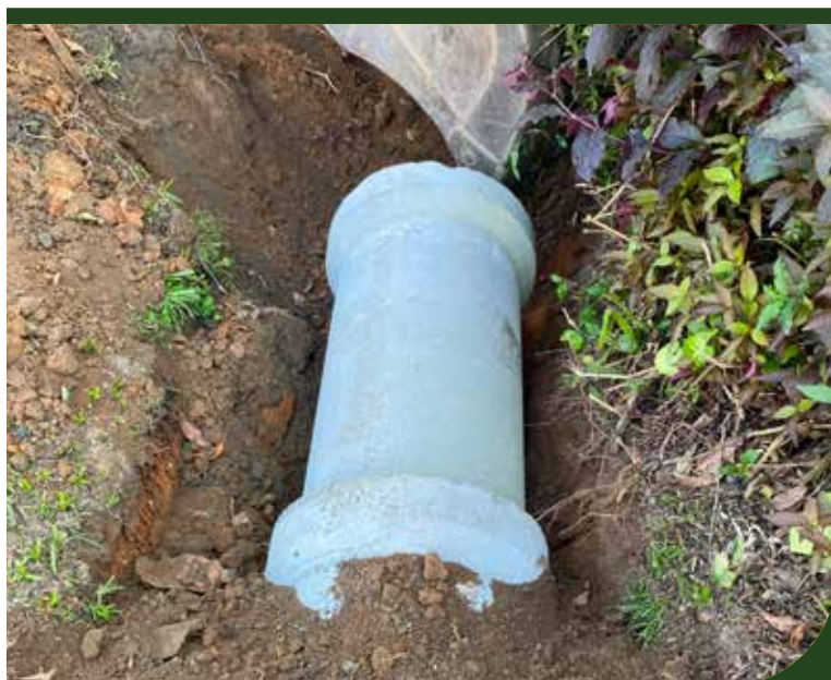
Término de instalação de manilhas na Rua Tapuia, no Caruara
