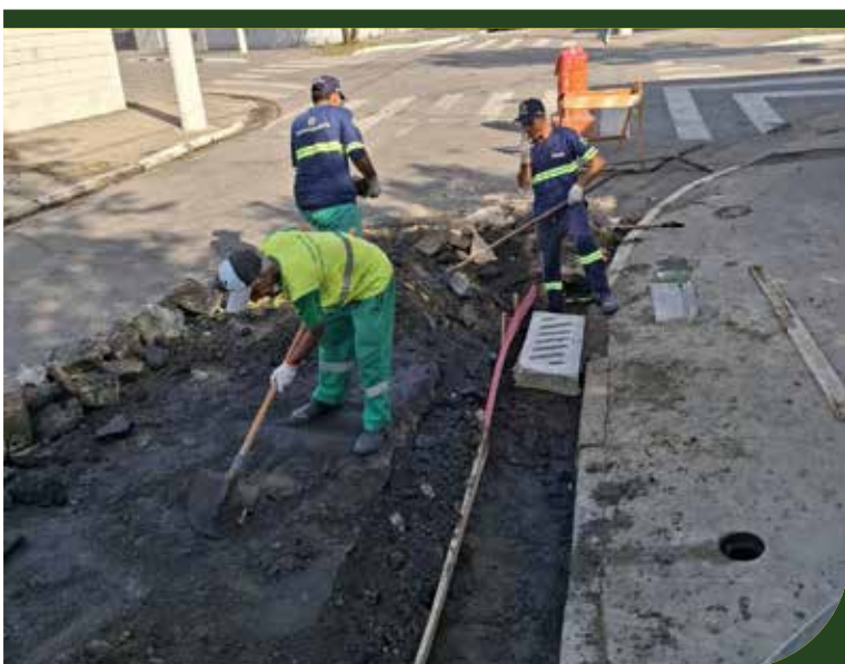
Serviço de recomposição de boca de lobo e sarjeta da Rua Professor Lucas Rodrigues Junot, no São Manoel
