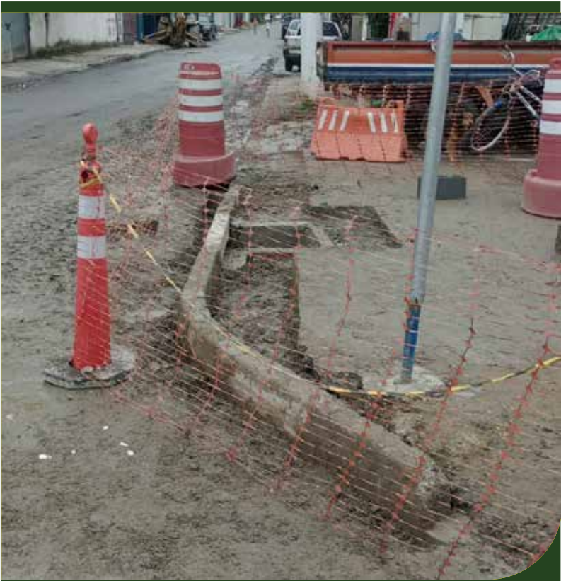
Adequação de guias na esquina da Rua Xavantes com Rua Andrade Soares, no Caruara
