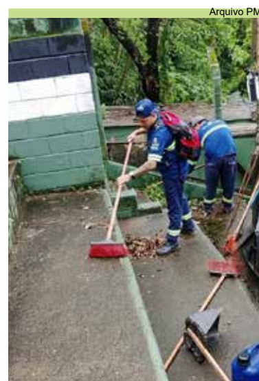
Serviço de limpeza no entorno da quadra esportiva do Ilhéu Alto
