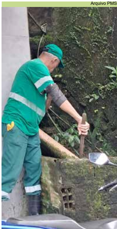
Limpeza de caixas, grelhas e córrego na Rua 6, no Morro José Menino
