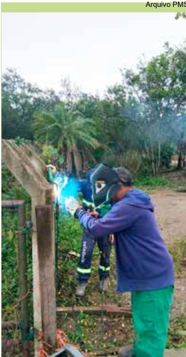
Instalação de portão de acesso à torre de celular no Caruara
