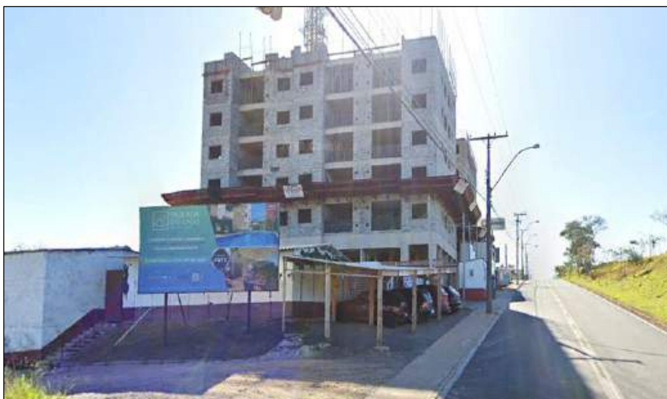
Figura 10. Condomínio Residencial Multifamiliar
