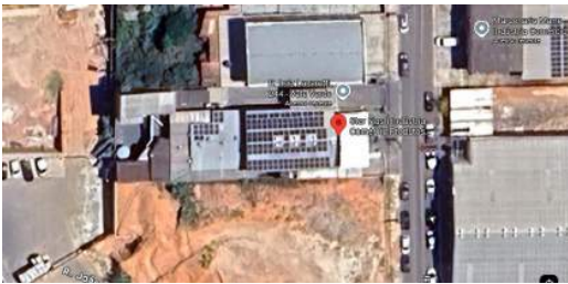
Localização das placas fotovoltaicas existentes ( será ampliado )
