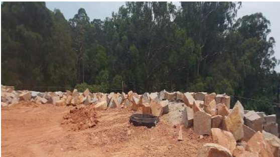
Imagem 08- Vista do ultimo trecho do muro incidente na APP.
