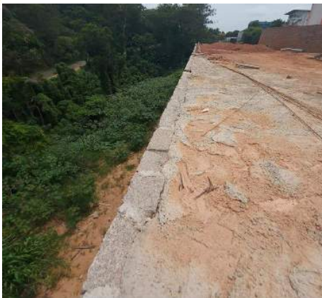
Imagem 05 – Muro de arrimo na APP
