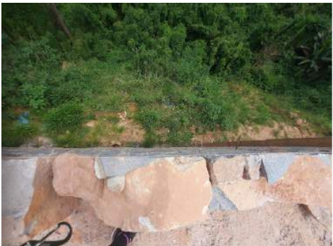
Muro na APP, Vista de cima .
