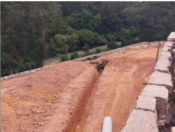
Imagem 02- Muro de arrimo, do 1º plantio, incidente na APP.
