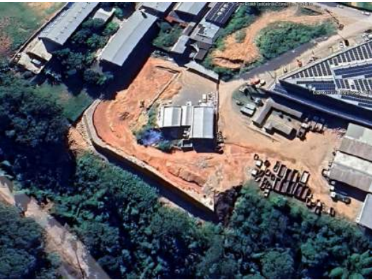
Fig. 01: Imagem aérea do terreno, com o Muro de arrimo
