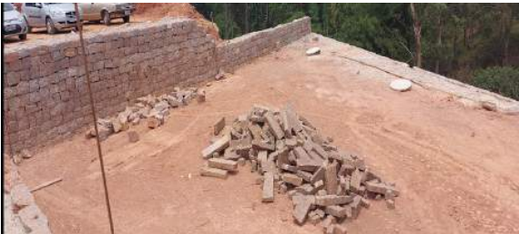
Imagem 01- Muro de arrimo, não incidente na Área de Preservação Permanente.
