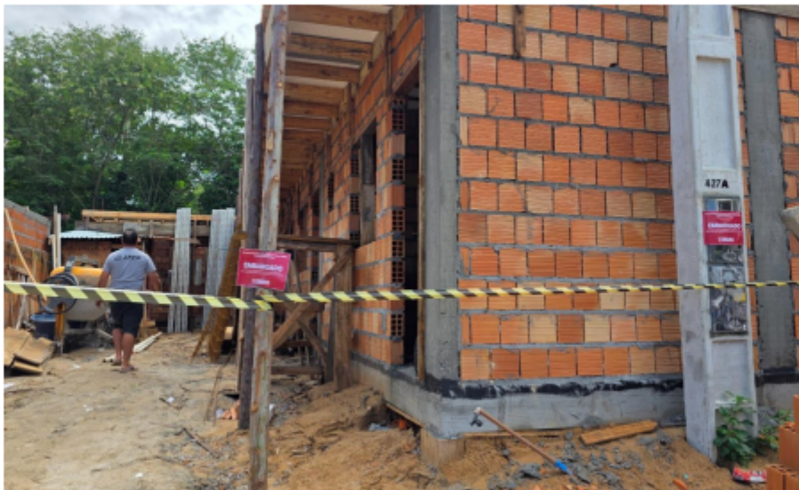
Imagem 2 – Foto da vistoria em 08/04/2026. Fonte: do autor.
