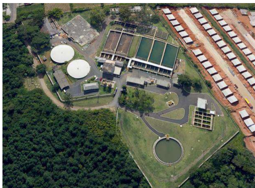
Figura 78 – ETA Campo Bom.
