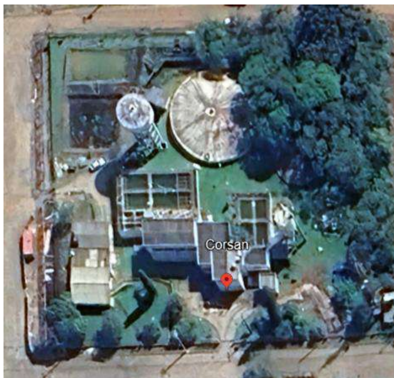
Figura 106 – Vista superior ETA Veranópolis.
