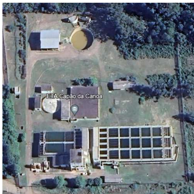
Figura 83 – ETA 2 de Capão da Canoa.
