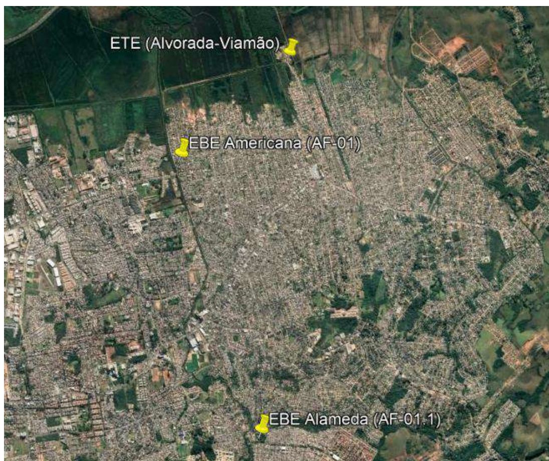
Figura 113 – Vista do SES Alvorada-Viamão.
