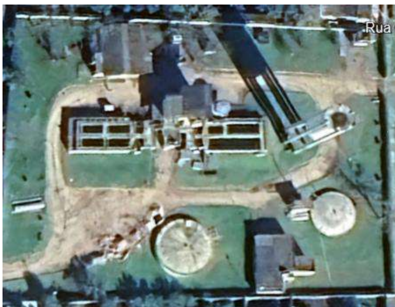
Figura 85 – ETA de Pedro Osório.
