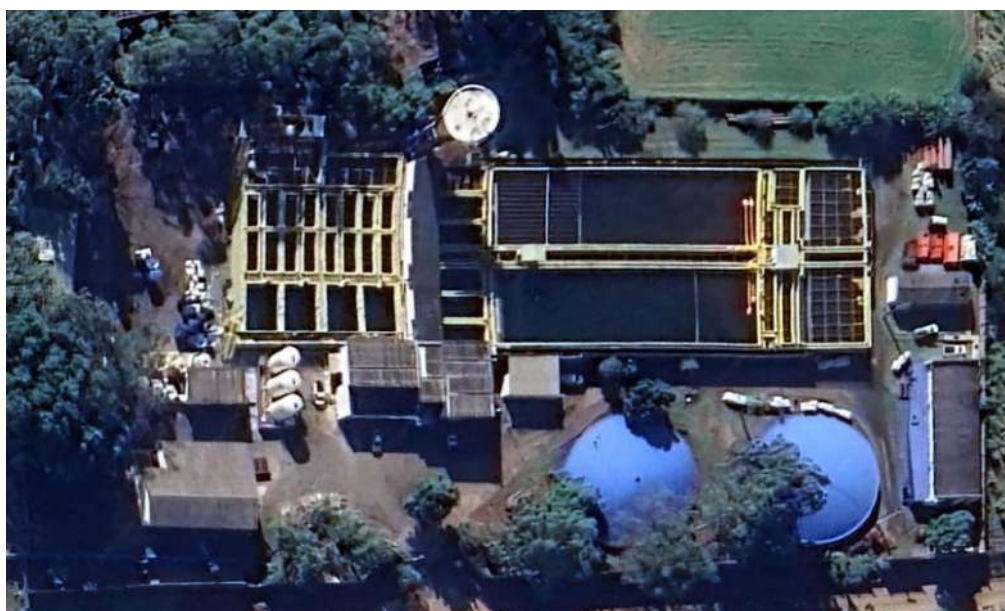
Figura 70 – Vista aérea da ETA Alvorada.
