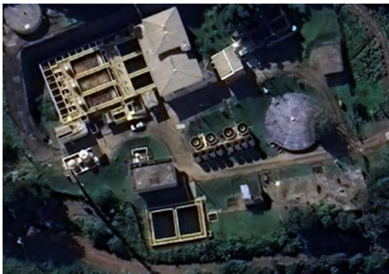
Figura 95 – ETA de Três Coroas.
