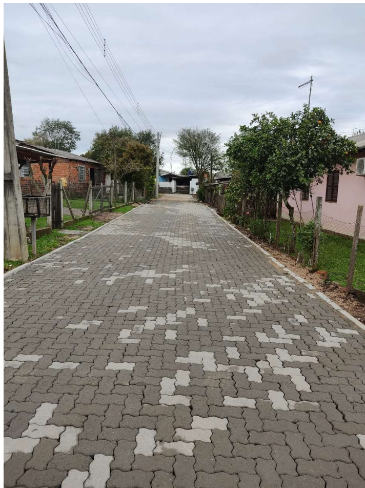
Trecho 03 – R. Corredor Otacilio
