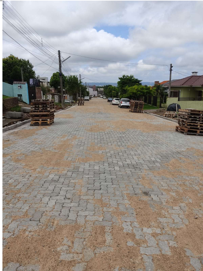
Lote 2 - Trecho 36: RUA JOSÉ ROHLFES
