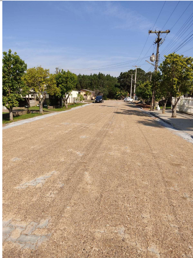
Lote 5 - Trecho 77: RUA HERBERT SCHNEIDER
